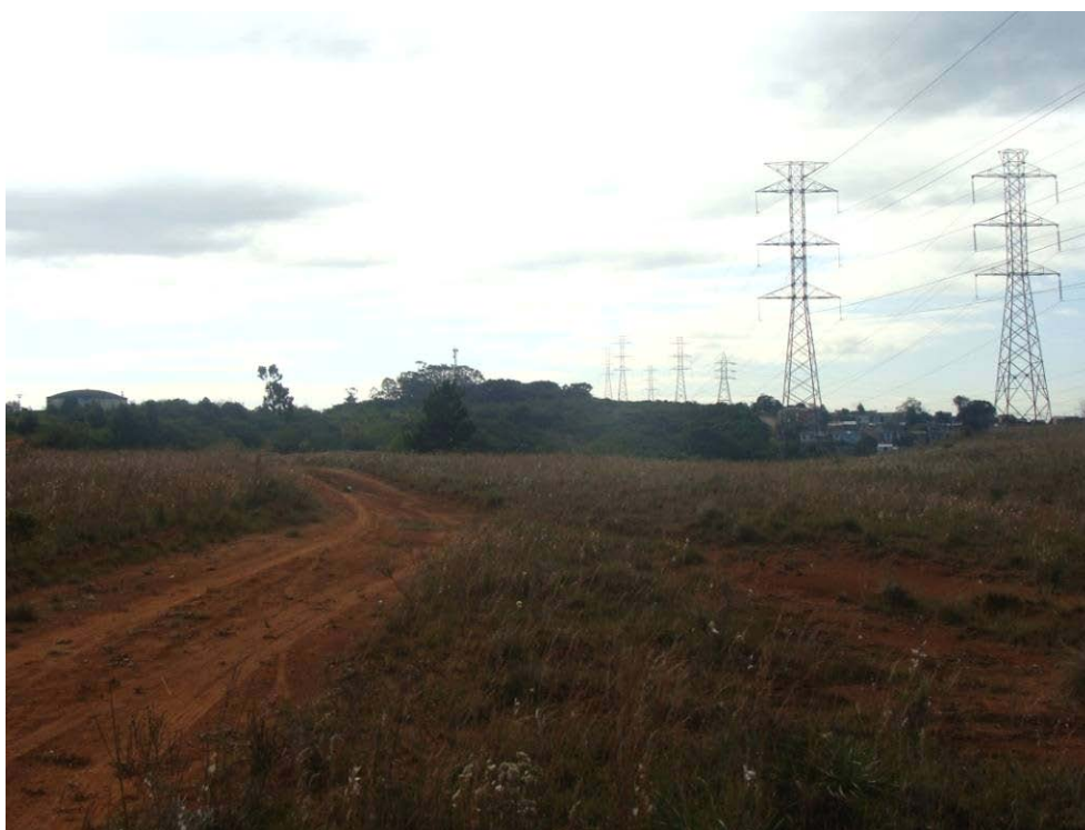
Figura 80 – Vista da LT 230 kV Gravataí II – Porto Alegre VI, ao sul da SE Viamão III (ponto B indicado na Figura 78)
