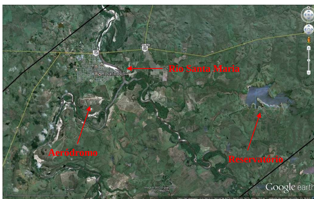
Figura 22 – Entorno da sede municipal de Rosário do Sul. Notar a presença dos rios de grande porte, do aeródromo e do reservatório de água. Limites do corredor em preto
