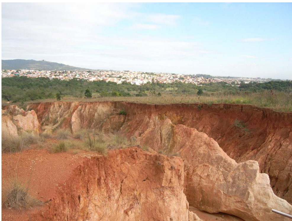
Figura 81 – Voçoroca próxima ao local previsto para implantação da SE Viamão III, ponto C (51°03'56.28"O/30°02'14.95"S), indicado na Figura 78
