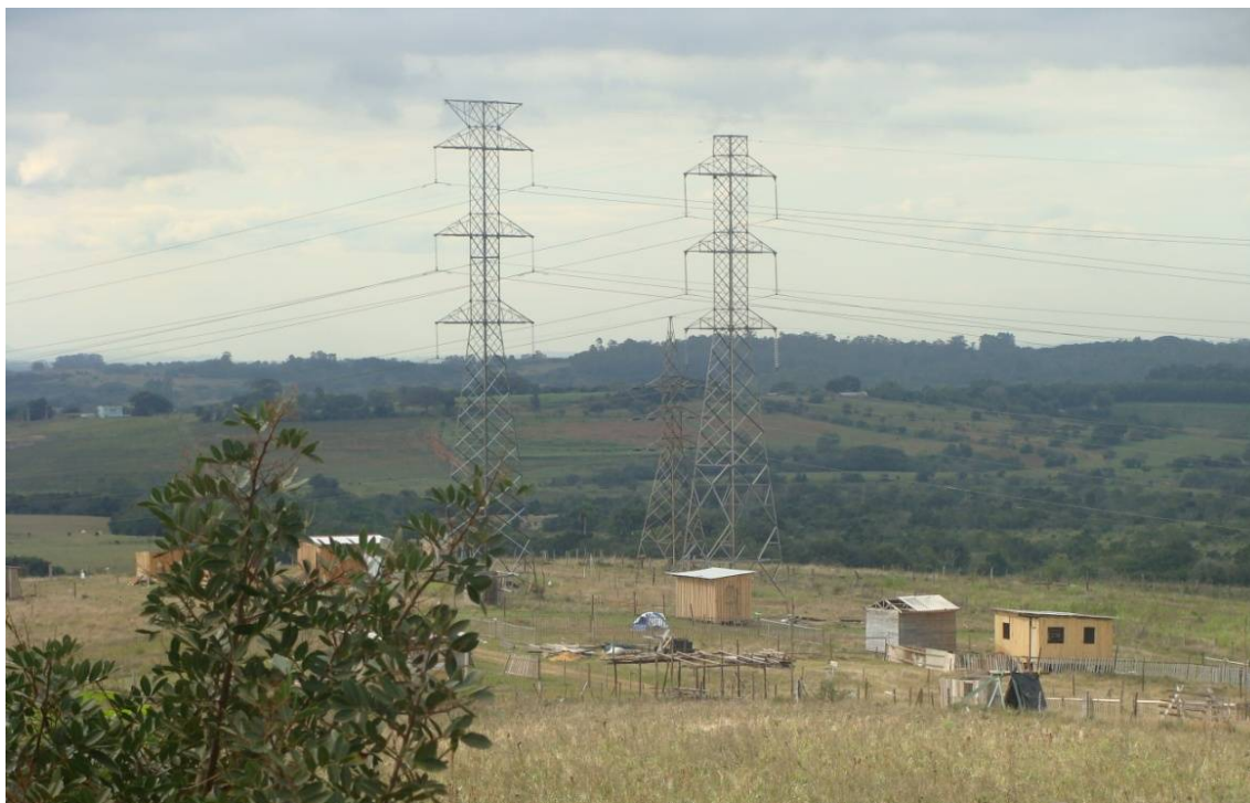
Figura 84 - Ocupação irregular ao longo da LT 230 kV Gravataí II – Porto Alegre VI (ponto D indicado na Figura 83)
